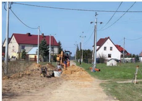
Droga na ulicy Młyńskiej w Szymonkowie w trakcie remontu.
