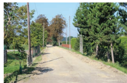
Droga w Wierzbicy Dolnej przed budową.
