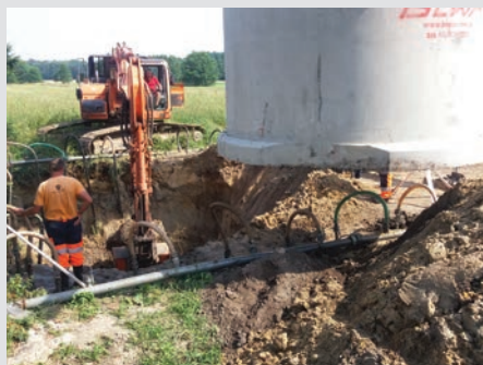
Budowa sieci kanalizacyjnej w Krzywiczynach.
