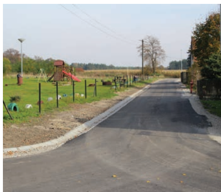
Ulica Opolska po remoncie.
