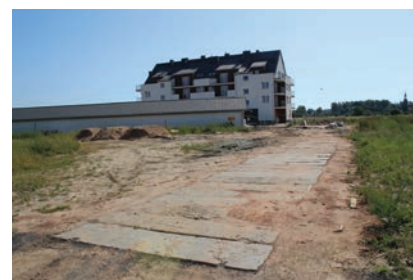
Ulica E. Orzeszkowej przed budową.
