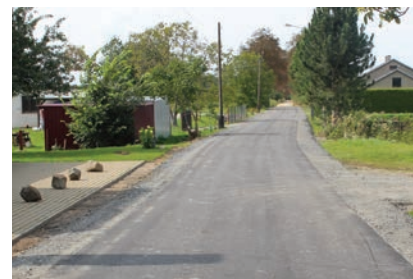
Wybudowana droga asfaltowa w Wierzbicy Dolnej.
