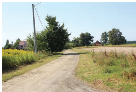
Ulica Główna przed remontem.
