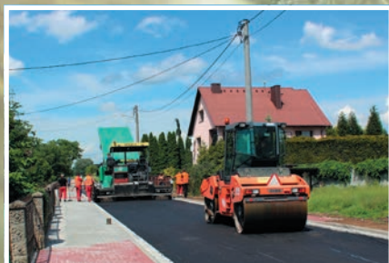
Budowa drogi na ulicy Polnej w Wołczynie
