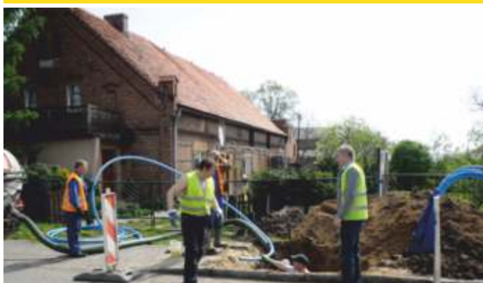
Wymiana przyłączy wody w Wierzbicy Górnej
