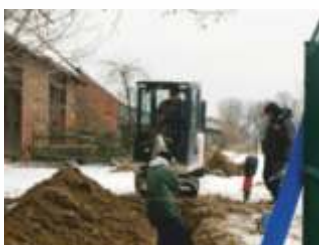
Budowa kanalizacji sanitarnej w Ligocie Wołczyńskiej
