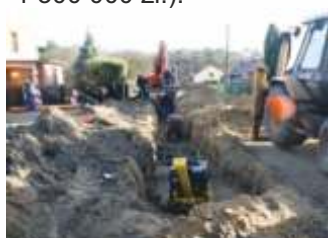
Budowa kanalizacji sanitarnej w Wierzbicy Górnej
