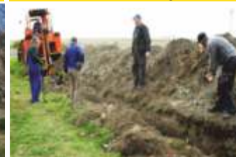
Budowa kanalizacji wodociągowej w Gieralcicach
