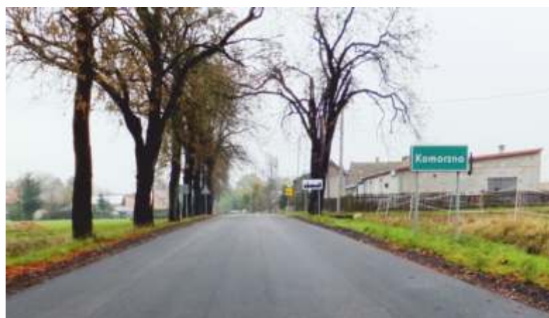
Droga powiatowa Nr DP 1337 O do Komorzna
