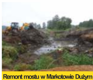
Remont mostu w Markotowie Dużym
