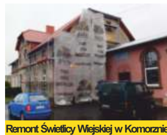
Remont Świetlicy Wiejskiej w Komorznie
