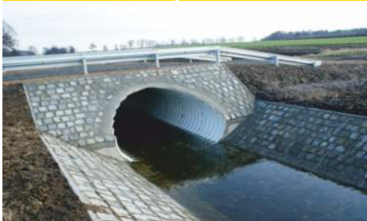
Przepust w Duczowie Wielkim
