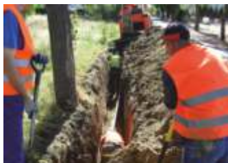
Budowa kanalizacji wodociągowej w Wołczynie ul. Astrów
