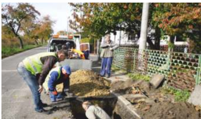
Wymiana przyłączy wody na ul. Ligonia w Wolczynie
