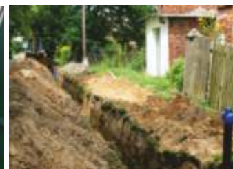
Budowa kanalizacji wodociągowej w Świniarach Małych
