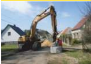
Budowa kanalizacji sanitarnej w Gieralcicach
