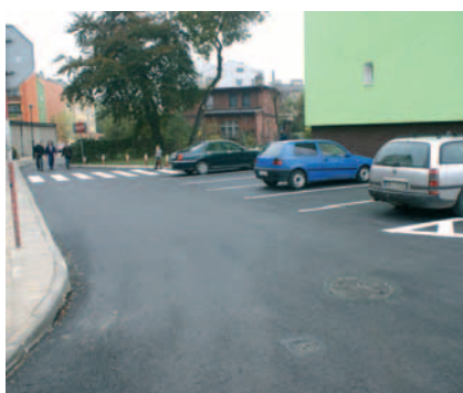
Już po remoncie
