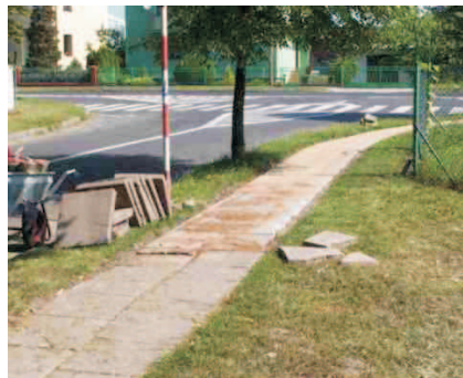
Remontowany chodnik przy ul. Kościuszki
